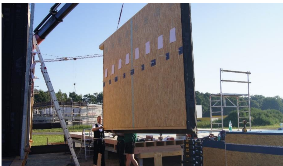
Abbildung 4: Die Wände mit den Gefachen wurden in der Werkshalle gebaut, zur Baustelle transportiert und dort zusammengesetzt (Foto: 3N)
