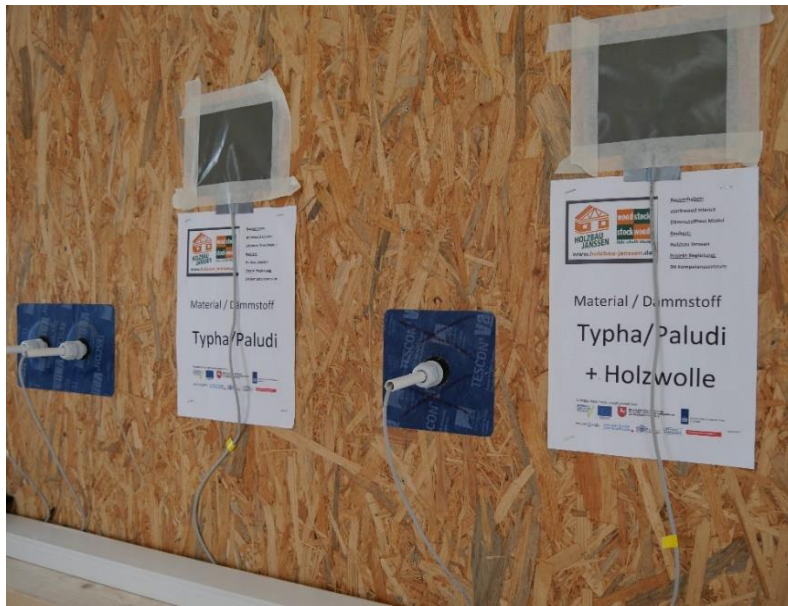
Abbildung 2: Die Außenwände des Science Cube wurde mit moderner Messsensorik ausgestattet. (Foto:3N )
