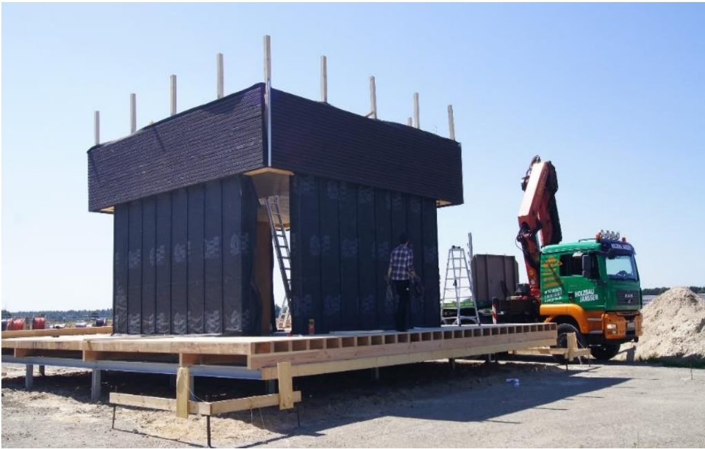
Abbildung 5: Das "Science Cube" der Holzbau Janssen GmbH wurde in Holzständerweise gebaut (Foto:3N )
