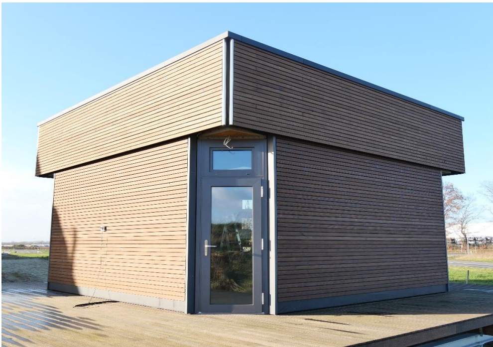
Abbildung 5: Das "Science Cube" der Holzbau Janssen GmbH wurde in Holzständerweise gebaut (Foto:3N )
